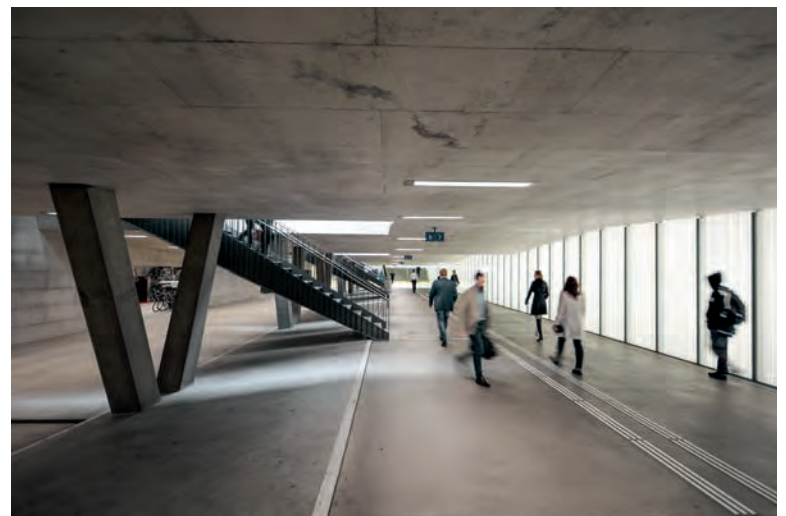
Die neue Quartierverbindung im Bahnhof Zürich-Oerlikon.
