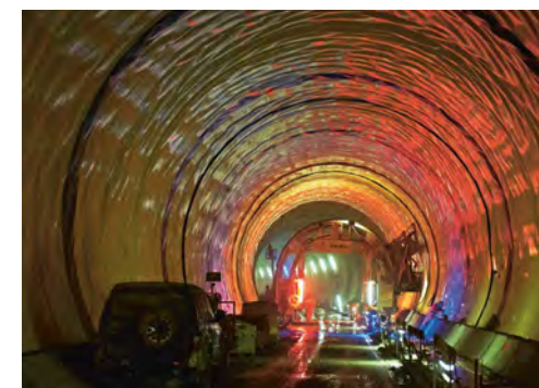
260 Bau des Weinbergtunnels
