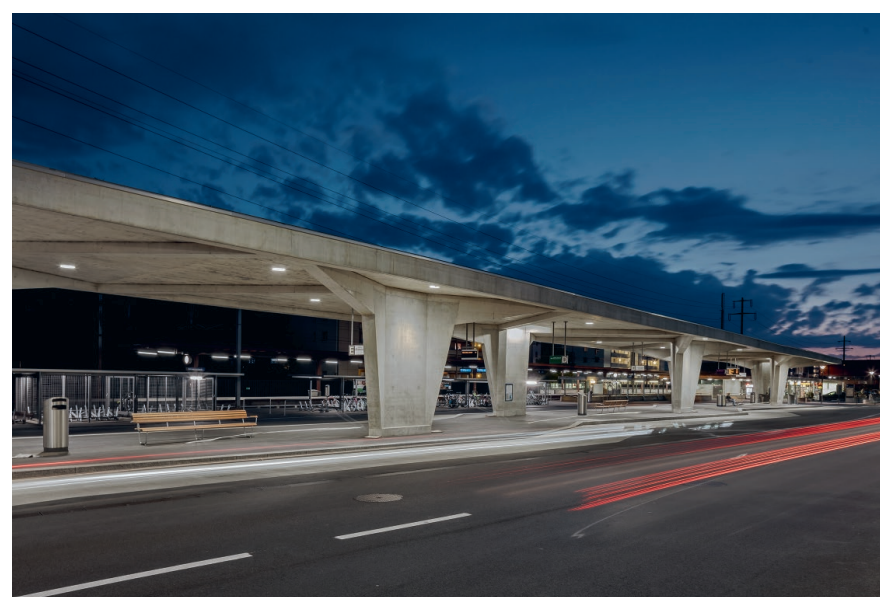
Die Überdachung des neuen Bushofs ruht auf sieben Stützen.
