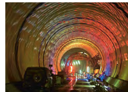
260 Bau des Weinbergtunnels
