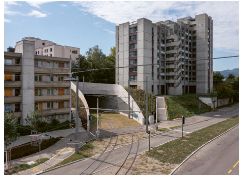
Der Färberhüslitunnel ist der einzige Tunnel der Limmattalbahn. Er verbindet das Gebiet Reitmen mit dem Spital Limmattal sowie der Kantonsschule Limmattal.
