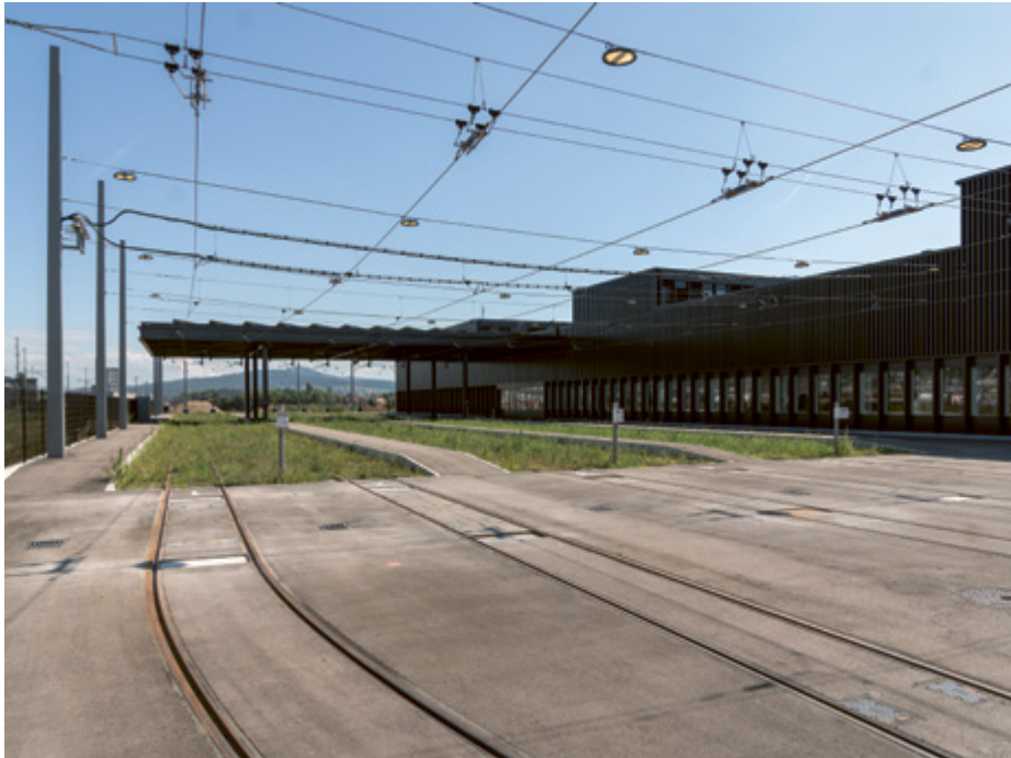
Depotgebäude Ansicht Nord mit Abstellanlage
