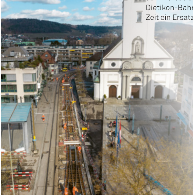
Baustelle beim Kirchplatz in Dietikon
