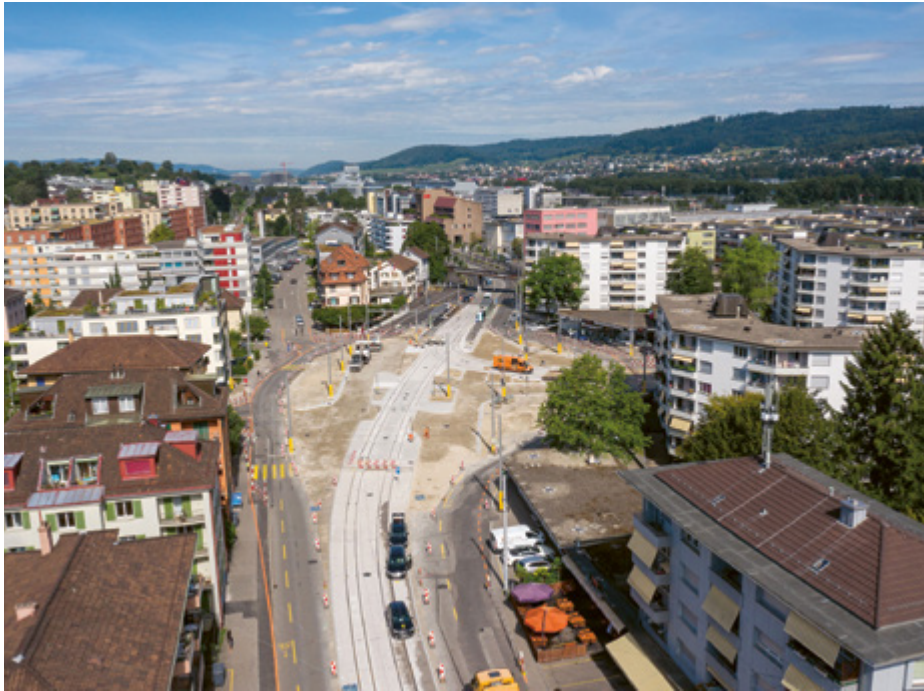
Intensivbaustelle Farbhof im Sommer 2019
