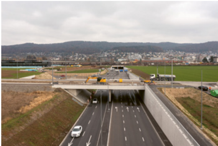
Mutschellenknoten mit Unterführungsbauwerk
