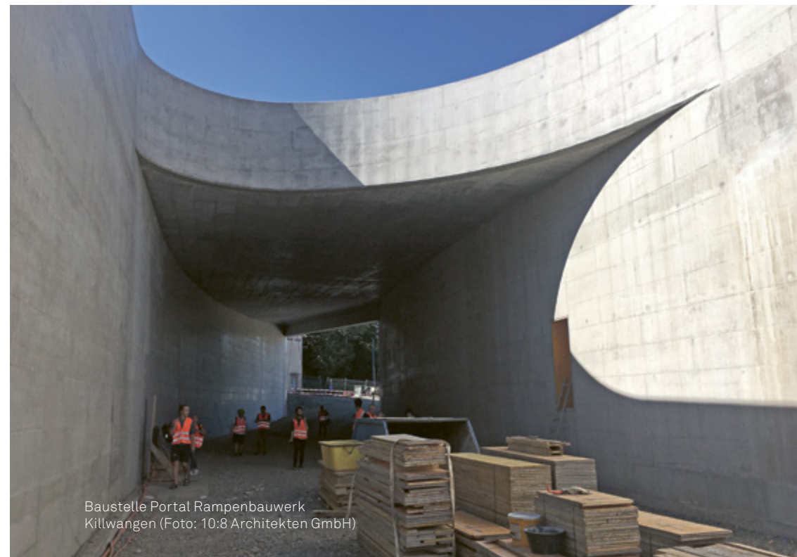
Baustelle Rampenbauwerk Killwangen
