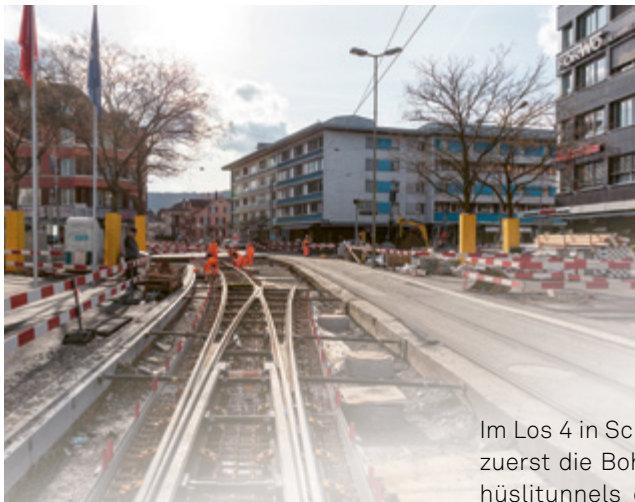
Trasseebaustelle im Zentrum Dietikon
