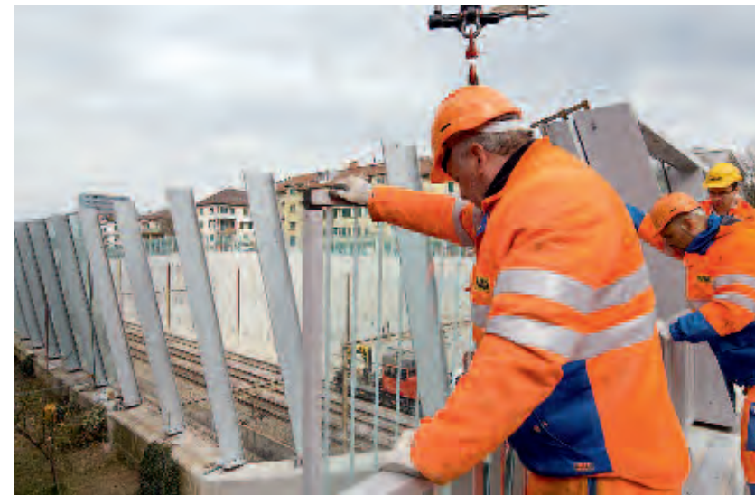
Arbeiter setzen Armierungseisen, um die Betonwände zu verstärken (links). Bau der Lärmschutzwände im Bereich des Birchstegs (rechts).
