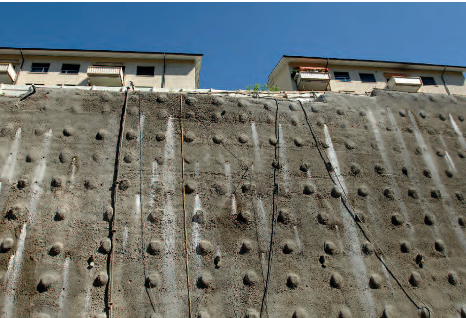
Die Stützmauer im Bauzustand. Die Wohngebäude veranschaulichen die engen Platzverhältnisse (oben). Der Kran trägt ein Schalungselement vor einem Wohnhaus durch zur Baustelle (rechte Seite).
