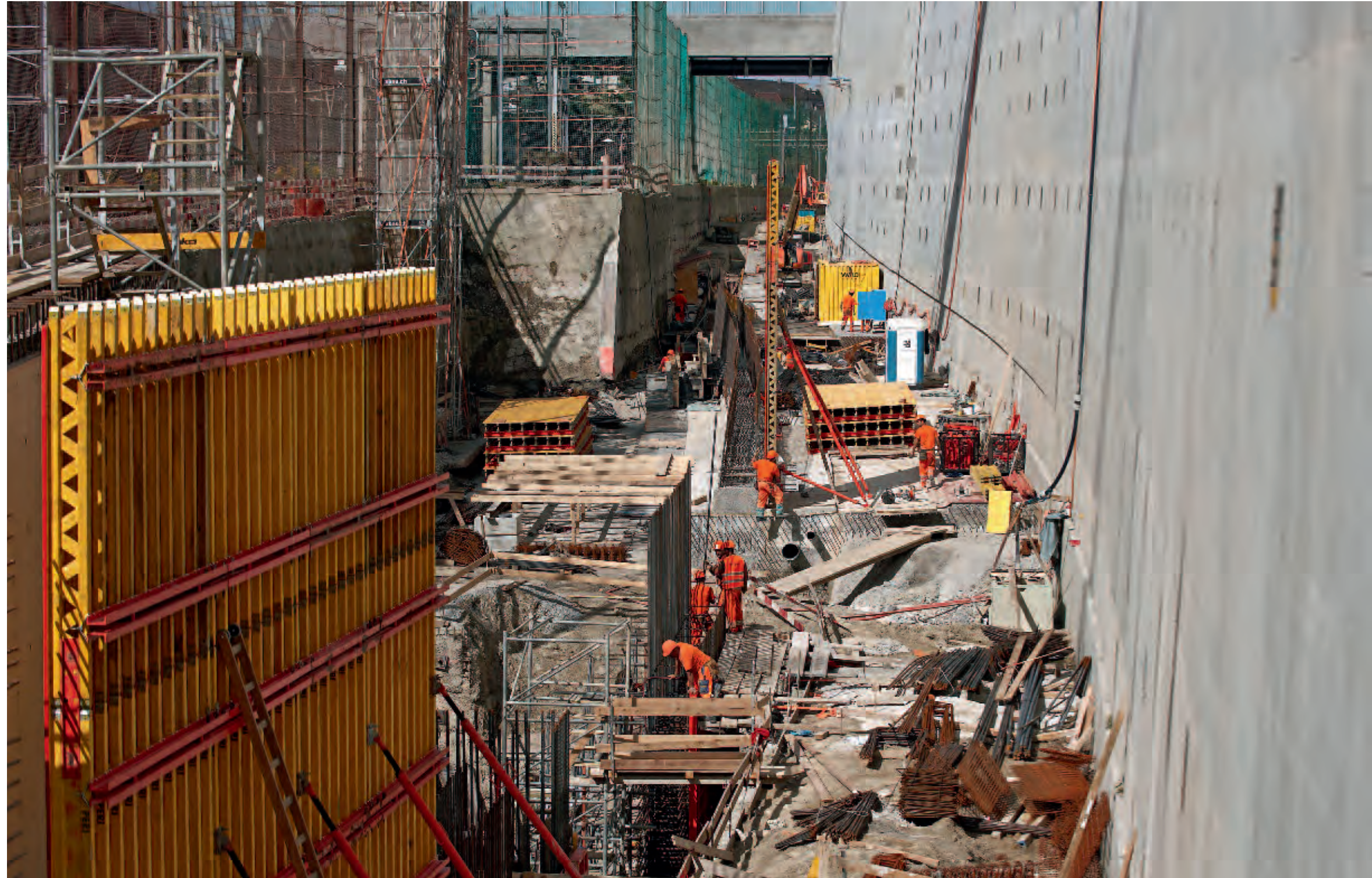
Arbeiter setzen Armierungseisen, um die Betonwände zu verstärken (links). Bau der Lärmschutzwände im Bereich des Birchstegs (rechts).
