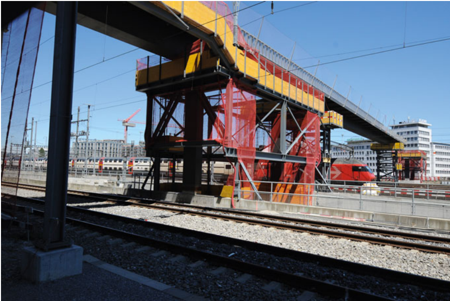
Die in Stahl gefertigte Brückenkonstruktion...
