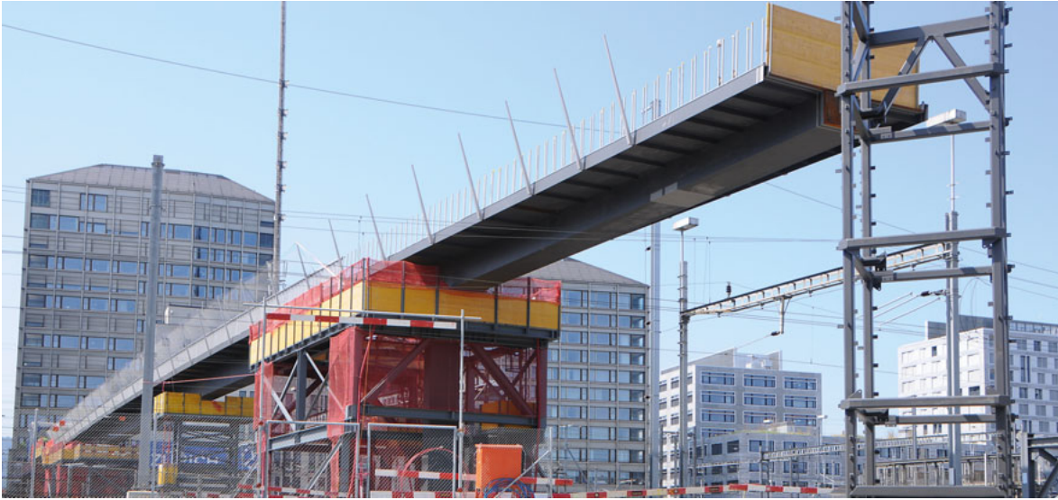
Am 24. Juli 2020 hatte der rund 300 Tonnen schwere Fussgängersteg seine Endlage erreicht (Stand der Aufnahme). Nachfolgend konnte er in die definitive Höhenlage abgesenkt und mit den Stützen verschweisst werden.
