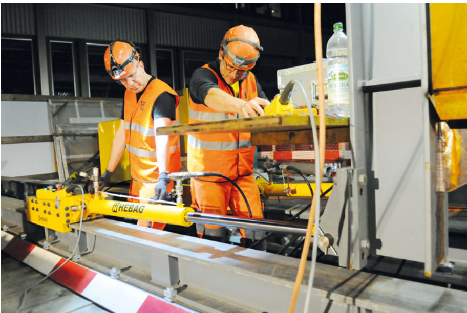
Zwei hydraulische Pressen stossen die im Endzustand 300 Tonnen schwere Stahlkonstruktion.
