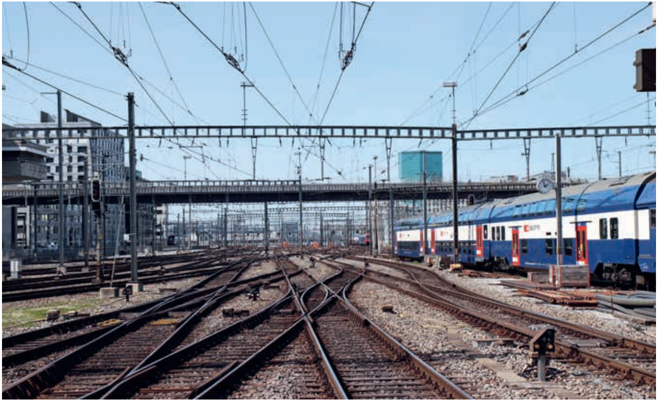
Blick vom Hauptbahnhof stadtauswärts: Die Pfeiler des Stegs sind auf Anhub kaum zu sehen. Der Durchlaufträger reiht sich visuell in die Bahninfrastrukturen ein.
