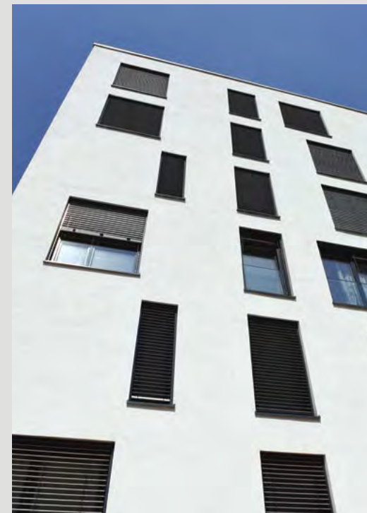
Automatisierte Storen sorgen für optimalen Hitze- und Blendschutz.
