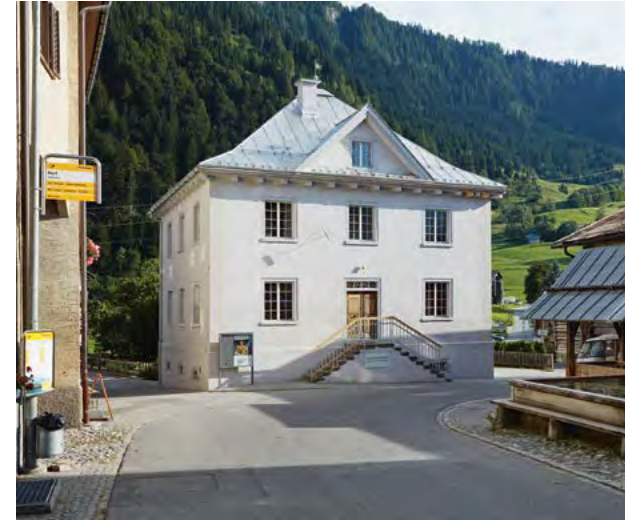
2_ Das alte Schulhaus, vom Dorfplatz aus gesehen, nach der Renovation.
