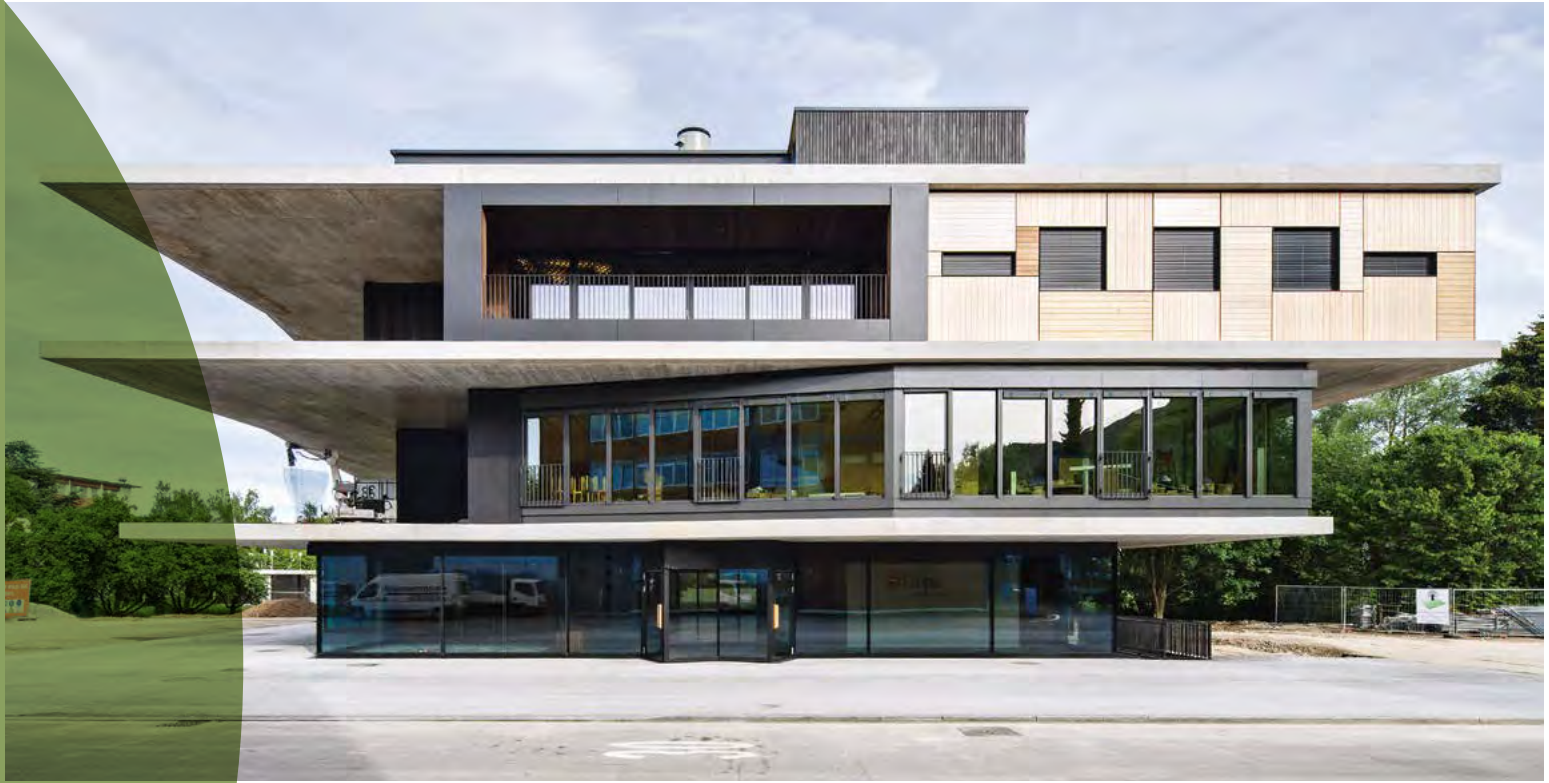
1_ Wie ein gestapeltes Quartier: In der permanenten Tragstruktur sind auswechselbare Forschungunits untergebracht. (Fotos: Roman Keller)
