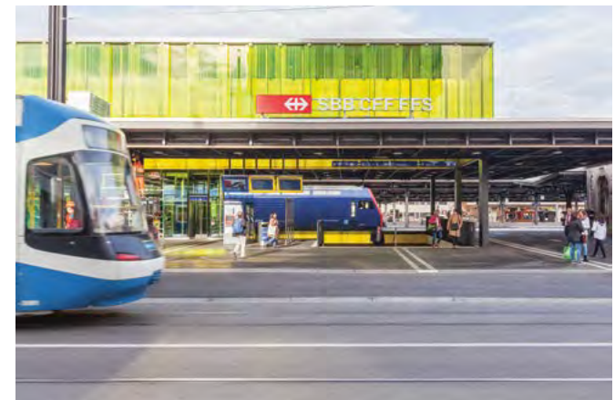
2_ Die Glasbaldachine wirken als weithin sichtbare Landmarken.
